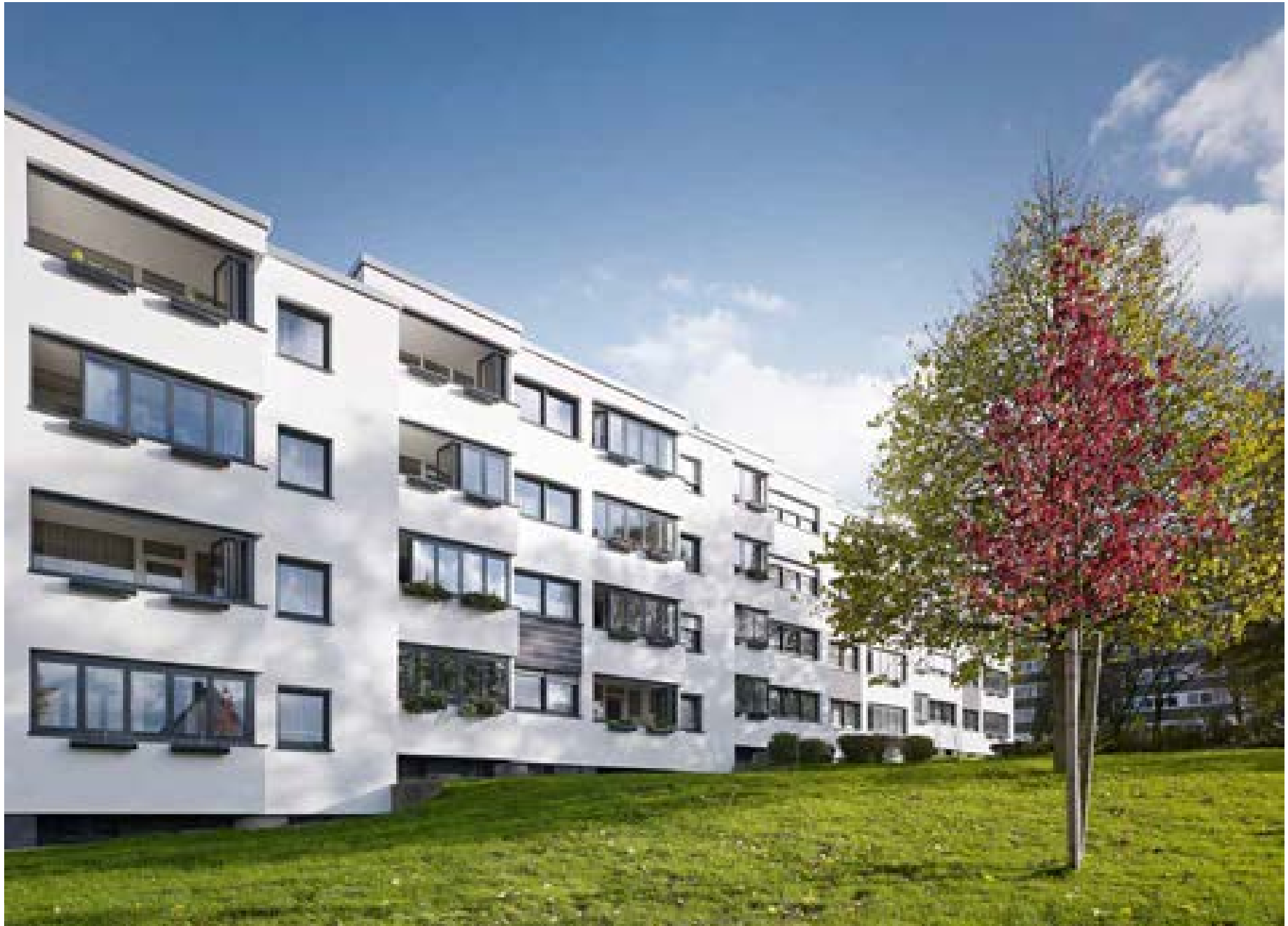
Balkons beglazen, ruimtes creëren · Hattingen, Duitsland
